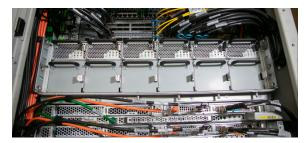
Chiffre 3 - AWS Outposts Alimentations AC-to-DC et distribution électrique par barre omnibus
