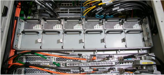
Figura 3 - Fontes AWS Outposts AC-to-DC de alimentação e distribuição de energia do barramento
